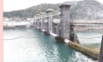
上流右岸から見た佐賀取水堰
